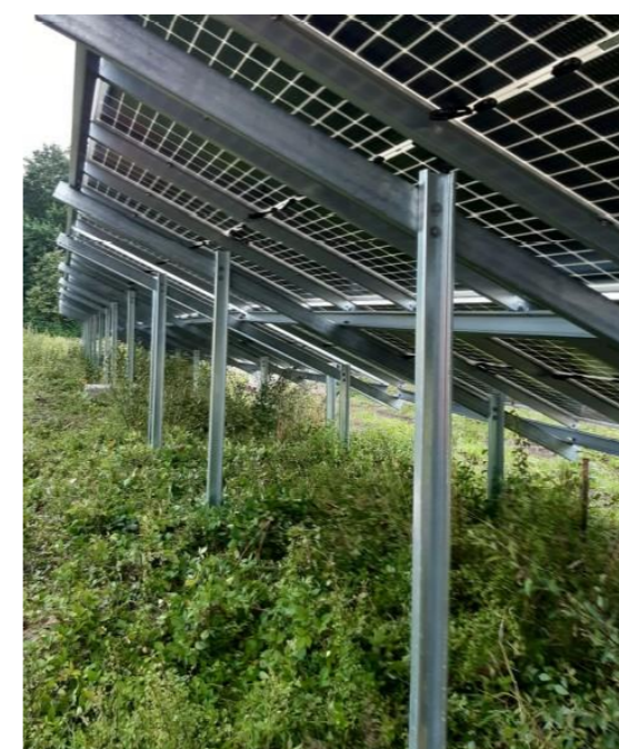
Photo 18 : ancrage des tables avec pieux acier
