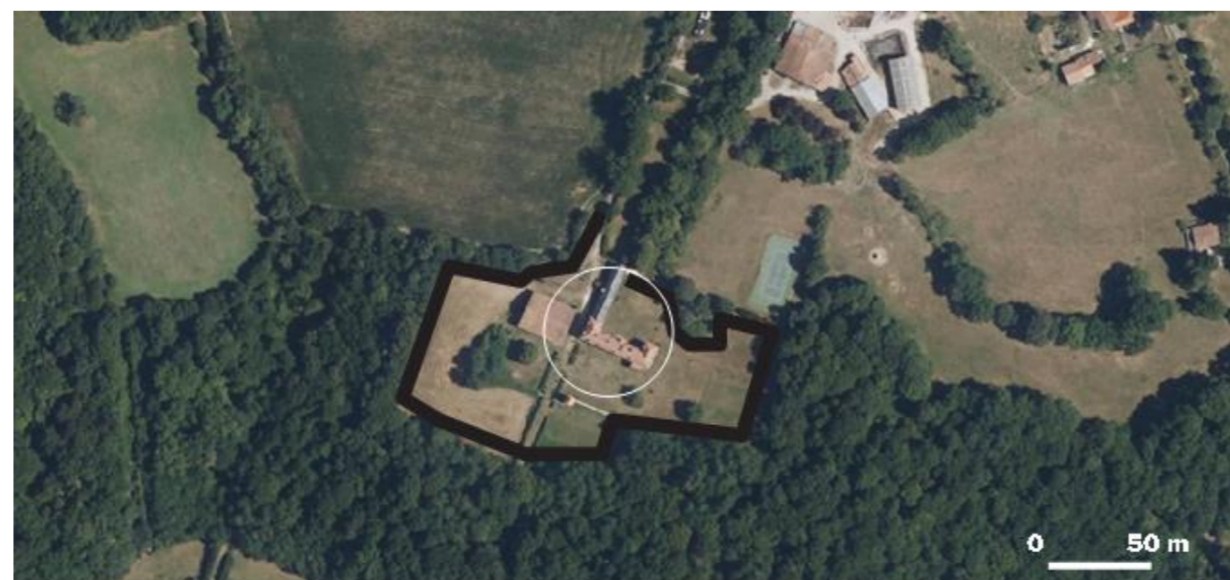
Figure 4 : Vue aérienne du château de Puybautier, en cœur de boisement (source : Geoportail)
