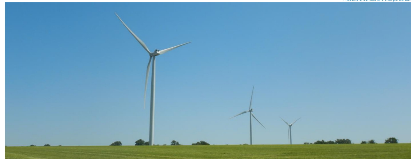
Photo 8 : trois des six éoliennes du parc éolien du Cofonlentais
