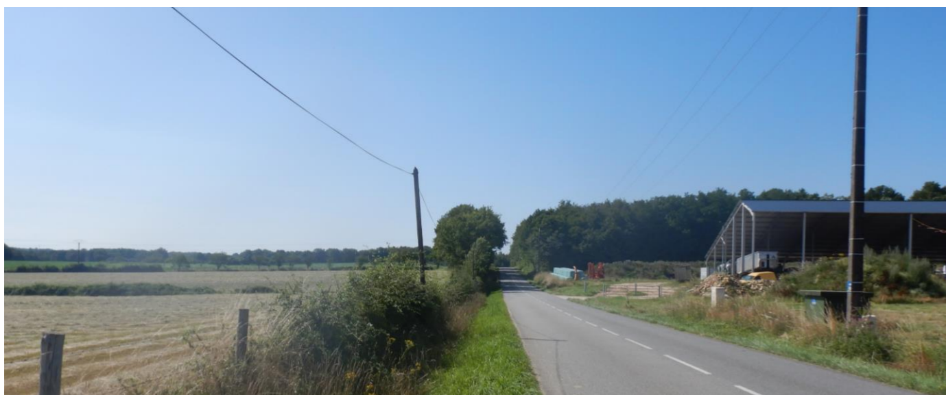
Photo 10 : artère aérienne Orange à l'ouest de la RD28 (à gauche sur la photo)
